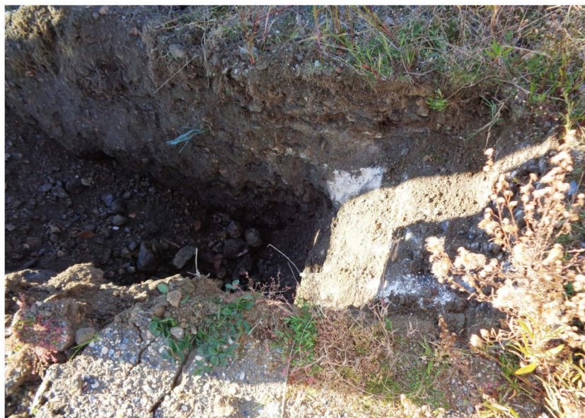
Foto N°3: dallo scavo appena iniziato si rileva la presenza di materiali vari (frammenti di laterizi, resti di legacci in materiale plastico, ecc..)
