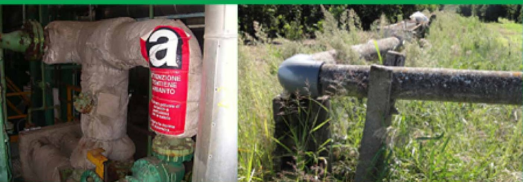
Coibentazione in amianto friabile
