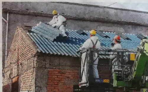
La delicata opera di rimozione. Operai al lavoro per bonificare un'abitazione
