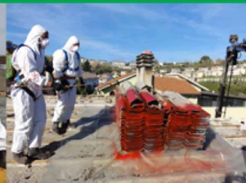
Operazioni di bonifica
