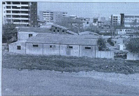
Un capannone e un tetto in eternit nell'area urbana
