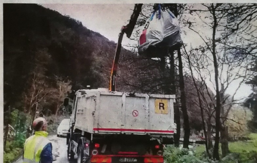
Lo smaltimento dell'amianto. Il composto di minerali deve essere trasportato in contenitori sigillati
