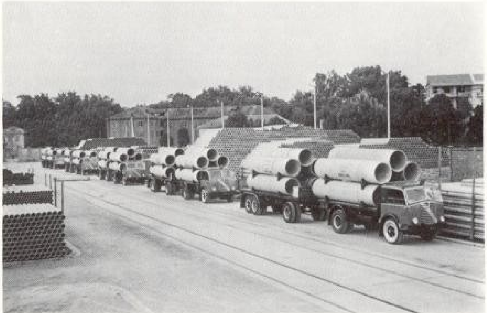
Le colonne degli autotreni, carichi di tubazioni in cemento-amianto necessarie alla costruzione del « nuovo acquedotto », in partenza per Padova dallo stabilimento di produzione. (Foto COLOMBINO - Cuscia M.)
