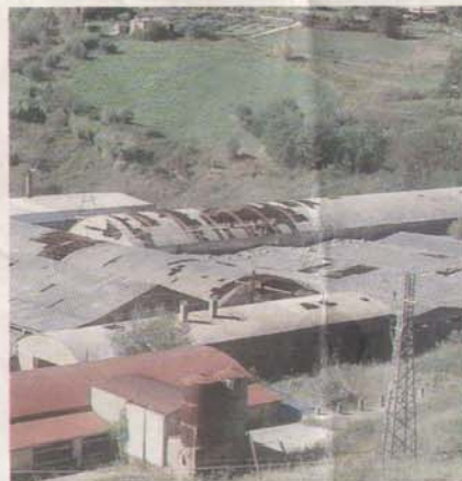
I capannoni ricoperti dall'eternit degli opifici di contrada Joggi
