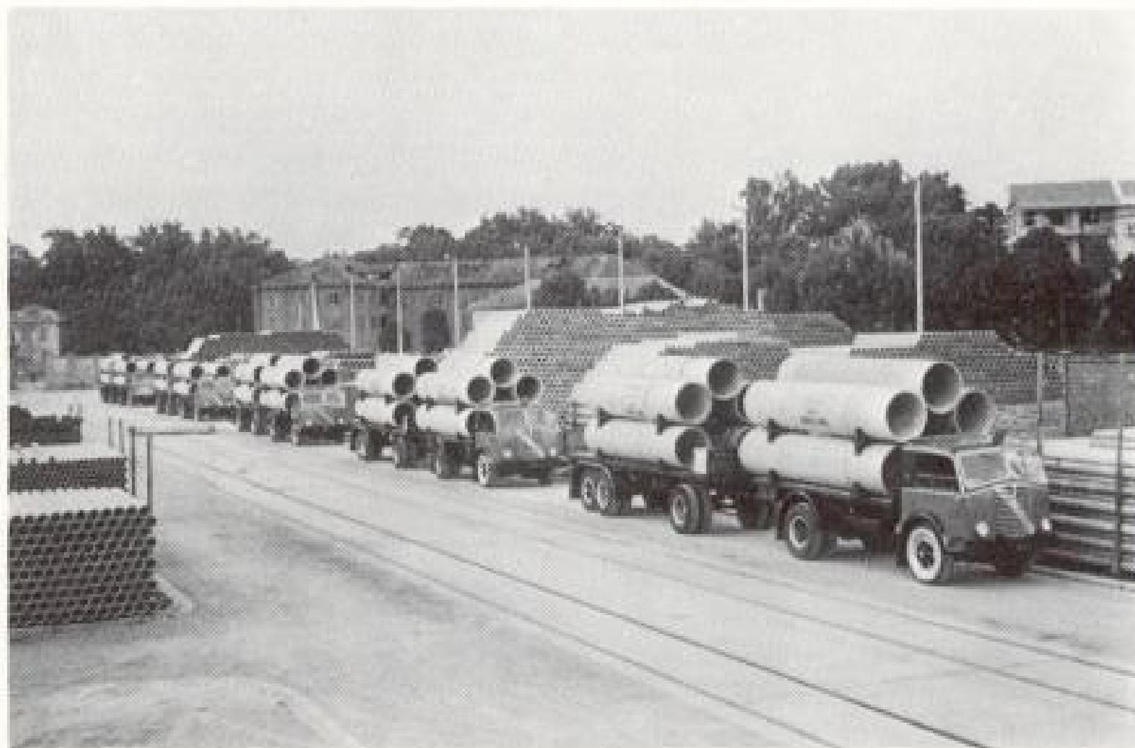
*Le colonne degli autotreni, carichi di tubazioni in cemento-amiante necessarie alla costruzione del « nuovo acquedotto », in partenza per Padova dallo stabilimento di produzione. (Foto COLOMBINO - Casa M.)*
