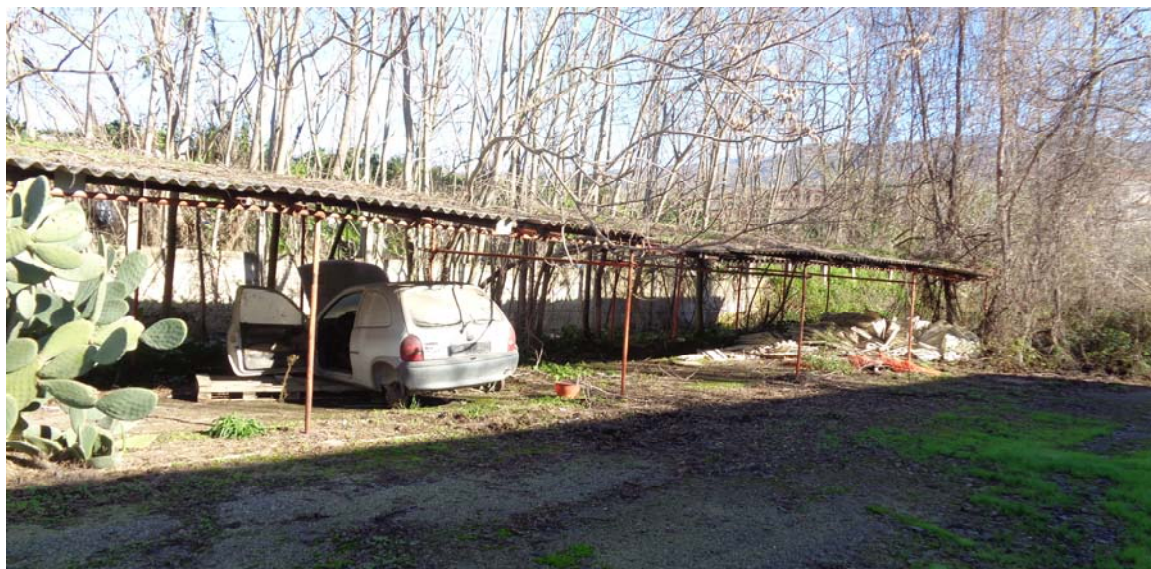
FOTO N°17 – Tettoia N°7 (v. precedente foto n°14) ove sono stati rinvenuti frammenti di lastre in cemento amianto sul suolo impermeabile (conglomerato bituminoso)
