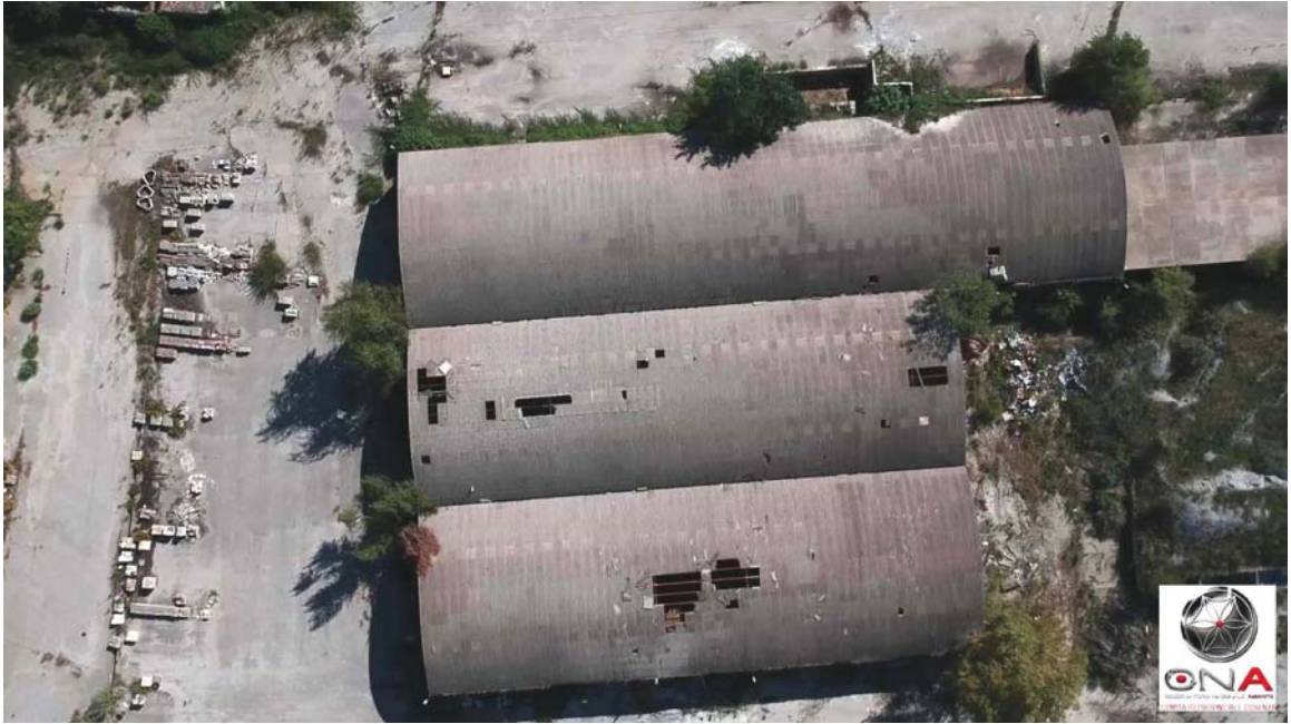
FOTO N°5 – Vista aerea delle coperture dei capannoni indicati con il N°1
