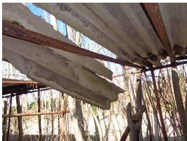
FOTO N°19 -Stato delle lastre di copertura (tettoia N°7)
