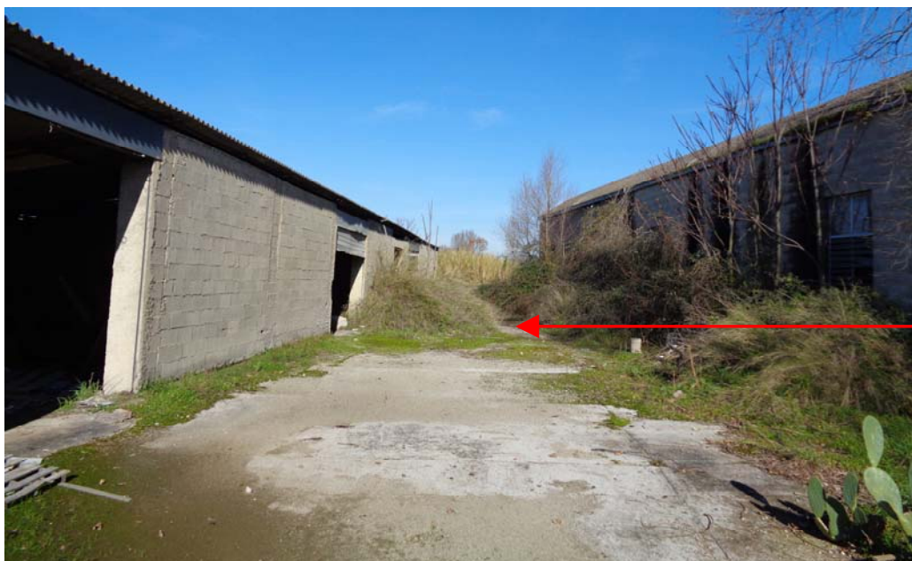
FOTO N°24 - Area tra il capannone N°2 ed il magazzino N°5 ove sono presenti frammenti di lastre in cemento amianto sul suolo pavimentato in calcestruzzo cementizio
