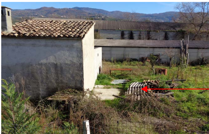
FOTO N°16 – Lastre di amianto accantonate nei pressi dei manufatti N°6
