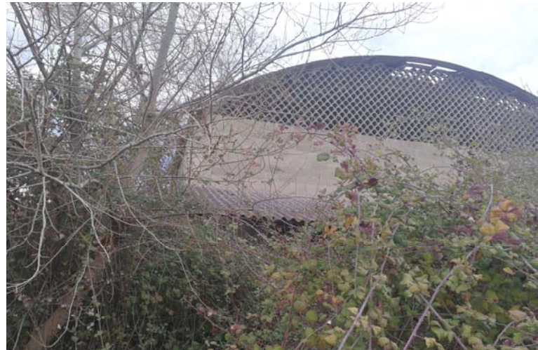
FOTO N°7 - Vista della tettoia sul fronte sud del cap. N°2
