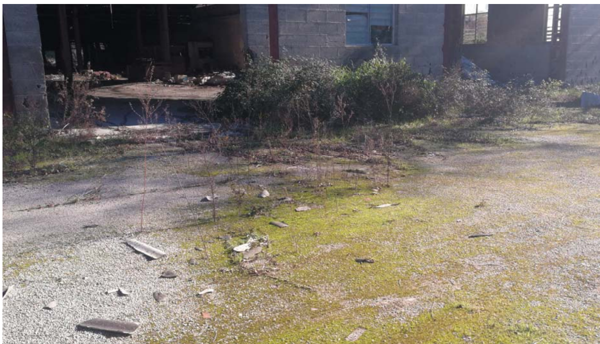
FOTO N°21 – Particolare dei frammenti presenti di lastre in cemento amianto nell’area di Foto N°20 e del tipo di suolo (calcestruzzo cementizio)
