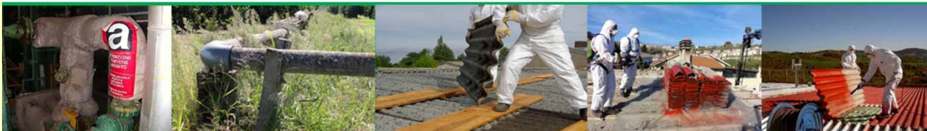
Coibentazione in amianto friabile
