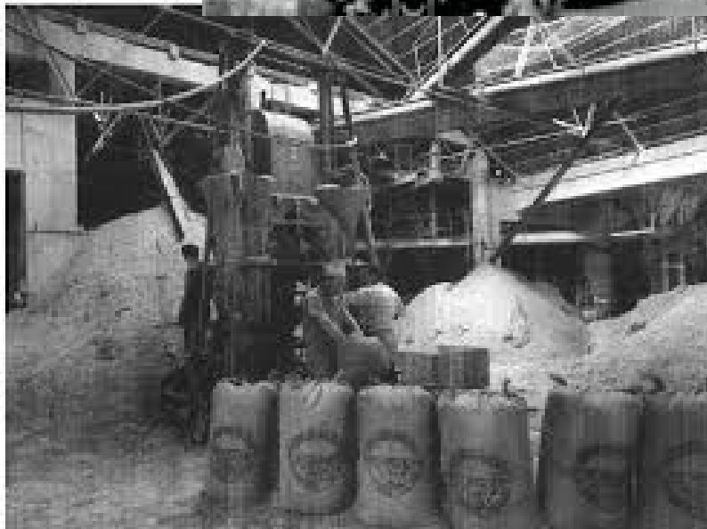
Impianto di produzione di amianto crisotilo nella miniera di San Vittore, Balangero
