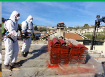
Operazioni di bonifica
