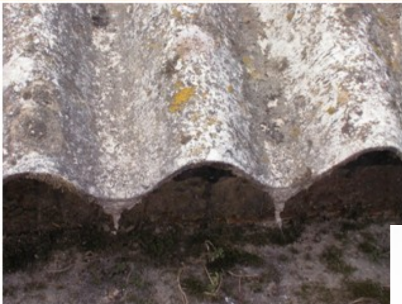
Stalattiti filamentose in corrispondenza dei punti di gocciolamento delle lastre ondulate di Eternit.
