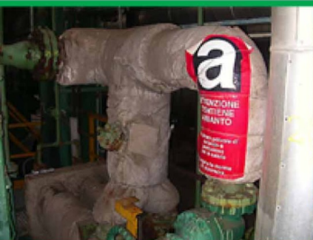
Coibentazione in amianto friabile
