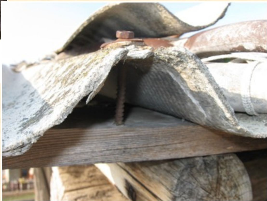
Stalattiti filamentose in corrispondenza dei punti di gocciolamento delle lastre ondulate di Eternit.
