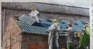
La delicata opera di rimozione. Operai al lavoro per bonificare un'abitazione
