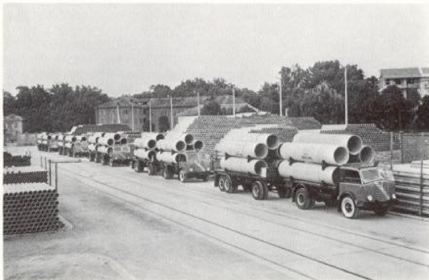
Le colonne degli autotreni, carichi di tubazioni in cemento-amianto necessarie alla costruzione del « nuovo acquedotto », in partenza per Padova dallo stabilimento di produzione. (Foto COLOMBINO - Cassia M.)
