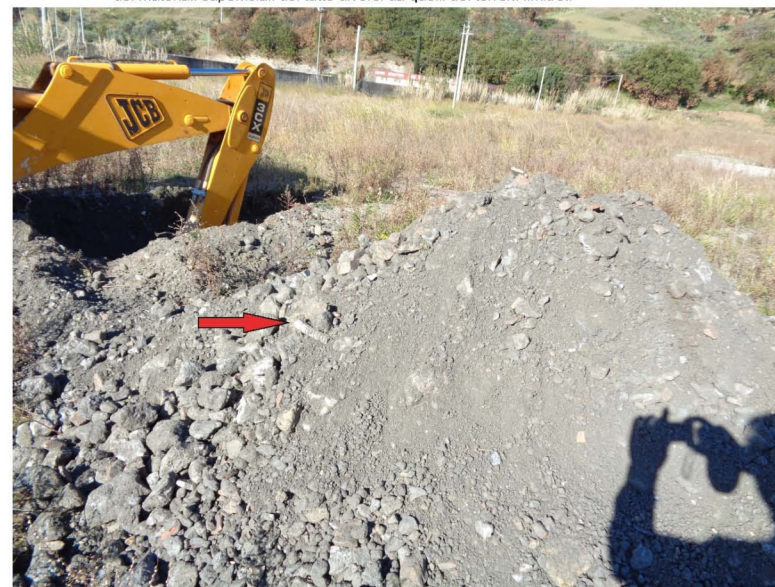
Foto N°4: con l'approfondimento dello scavo si osserva presenza di materiali di varia colorazione, frammenti a pezzi di mattoni, mattonelle, materiale cementizio e plastico; la freccia indica un grosso tassello in plastica
