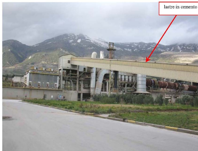
P.V. 5 - FOTO N°6: passerella aerea per alloggiamento nastro trasporto granuli alla griglia Lepol (10) - non bonificata
