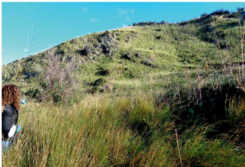
Foto N°13: vista della collina sovrastante la galleria ferroviaria
