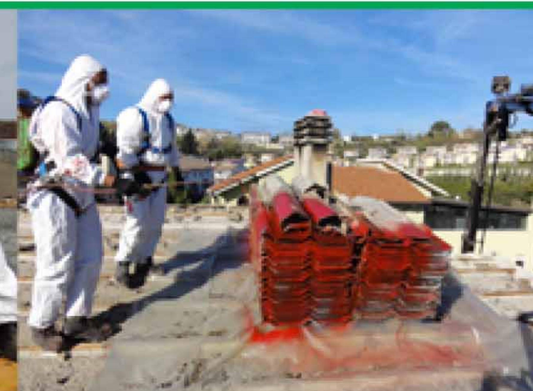
Operazioni di bonifica
