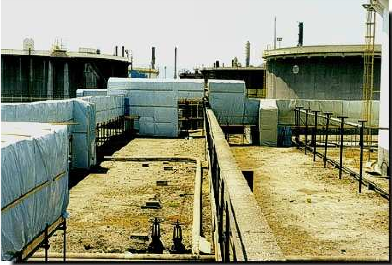
Figura 63 - Predisposizione area di cantiere
