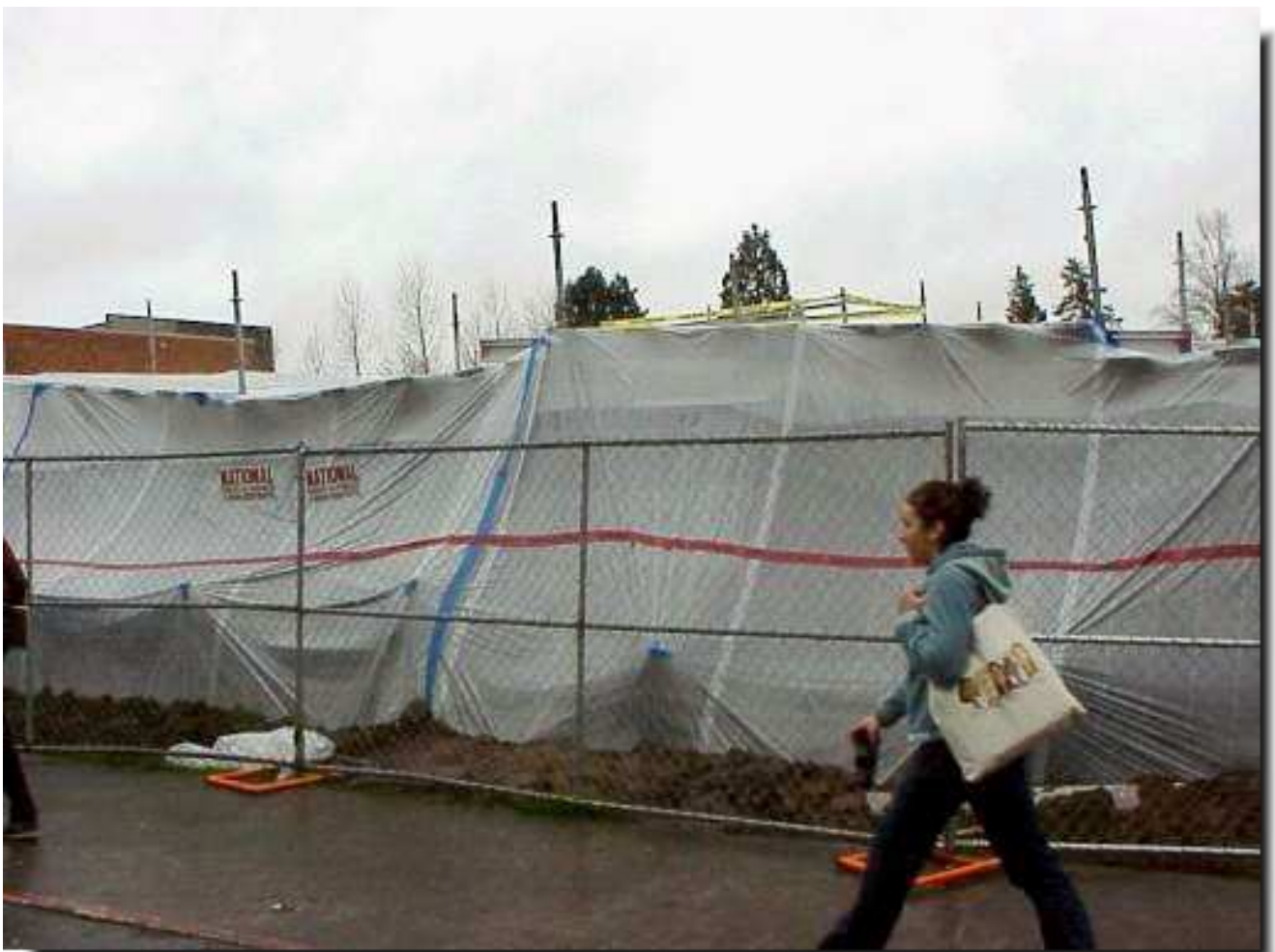
Figura 19 - Cantiere di lavoro
