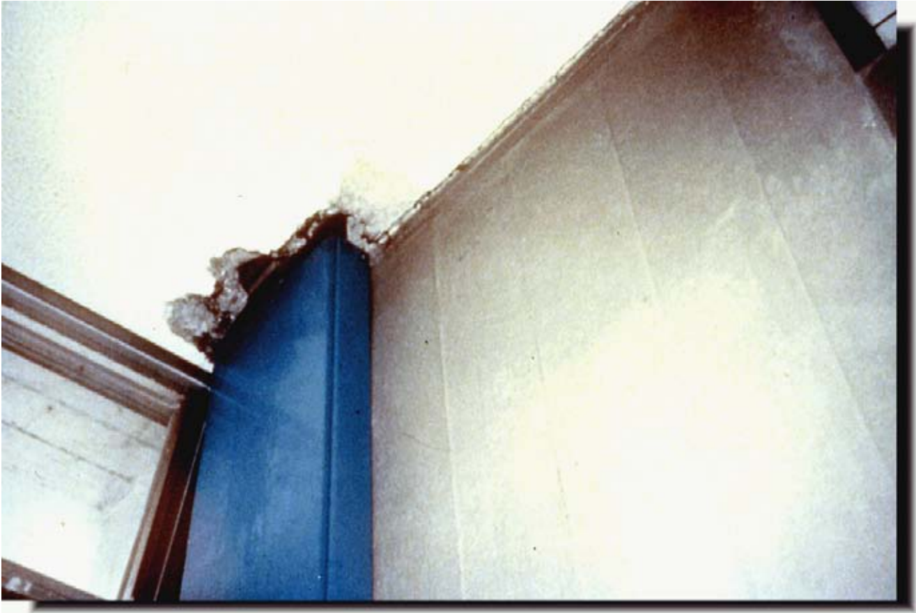
Figura 13 – Degrado spontaneo di solaio contenente amianto
