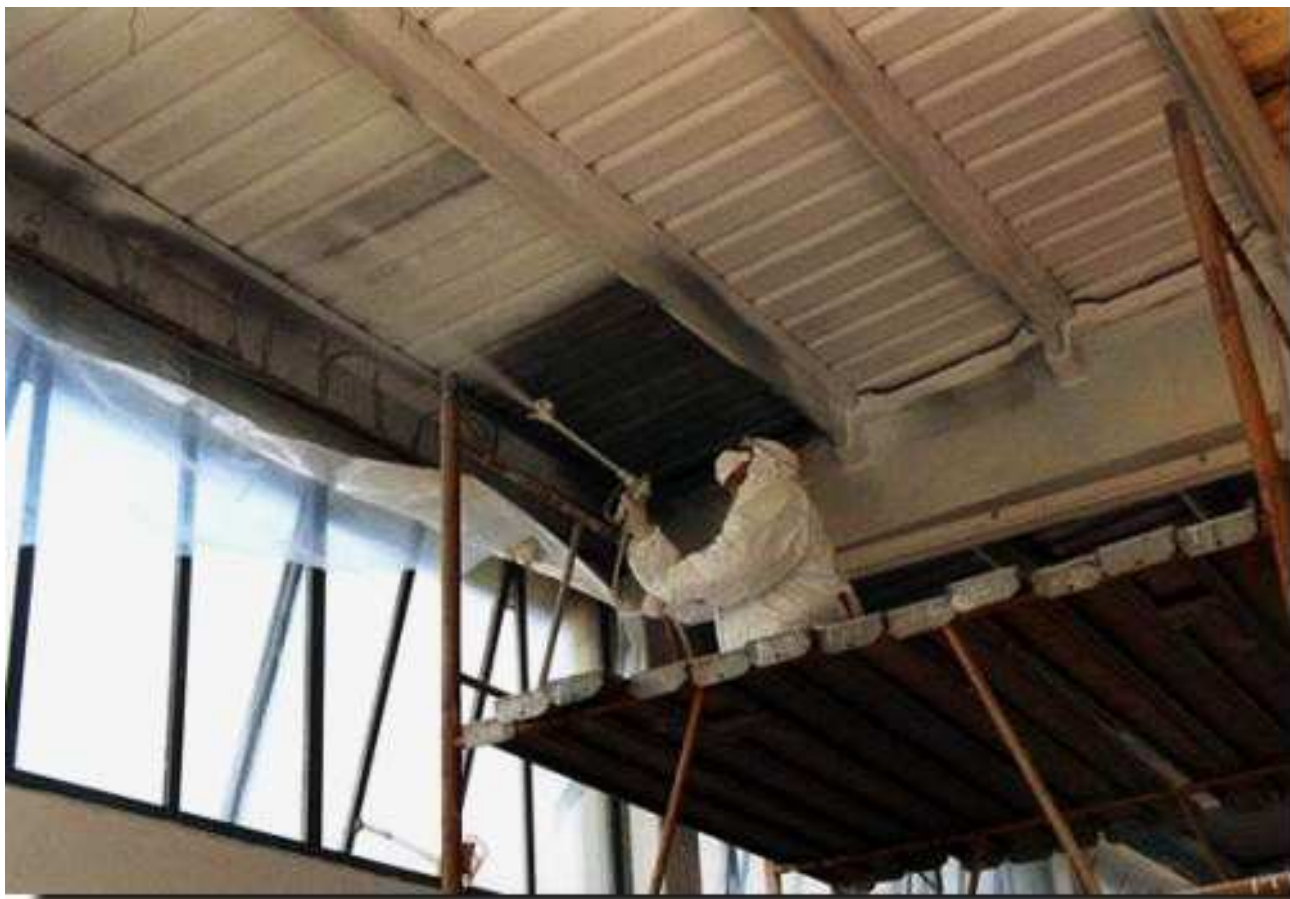
Figura 62 - incapsulamento
