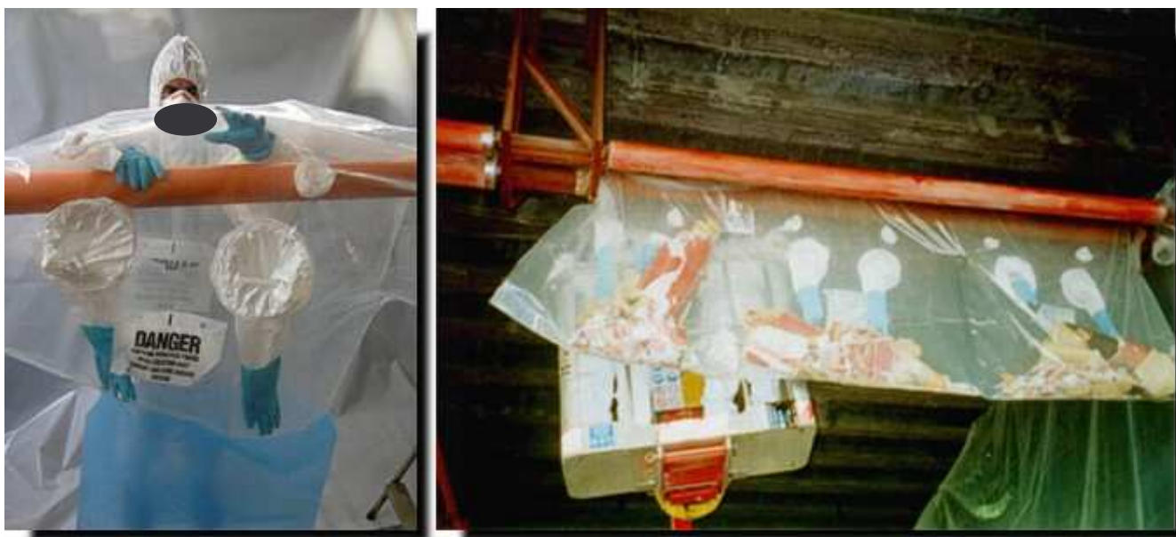
Figura 49 - Tecnica del Glove-Bag
