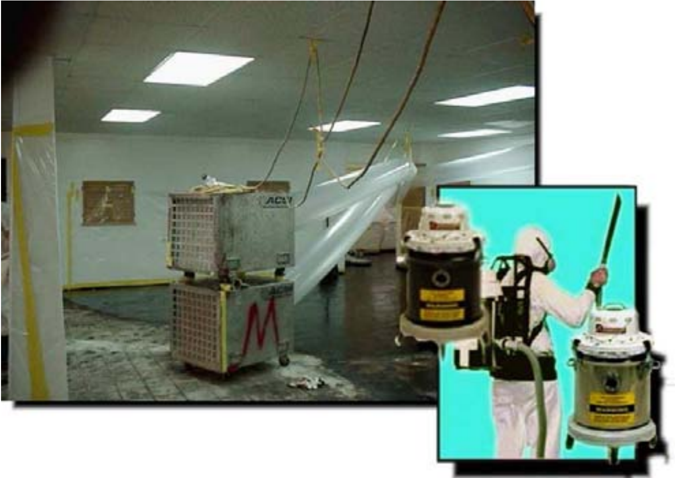
Figura 21 - Filtro HEPA montato nell'estrattore d'aria e negli aspiratori portatili
