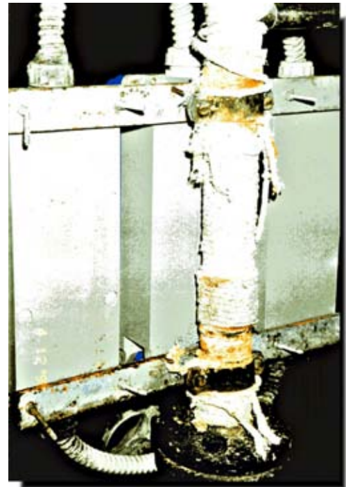
Figura 10 Amianto in corda per isolare termicamente tubazioni o per sigillare focolari
