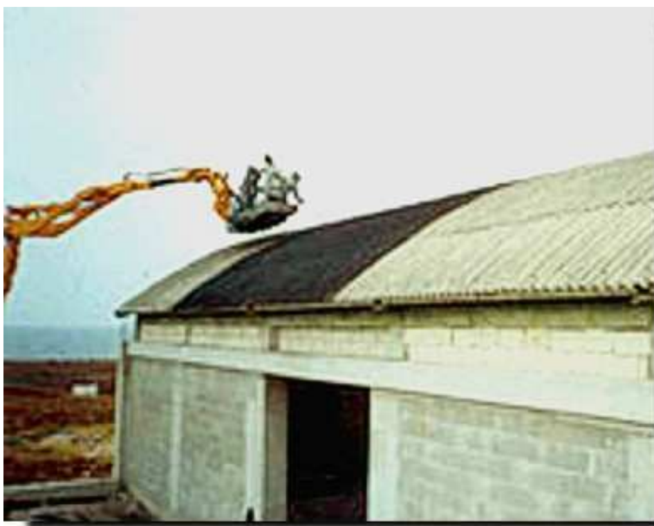
Figura 61 - Posa della sovracopertura
