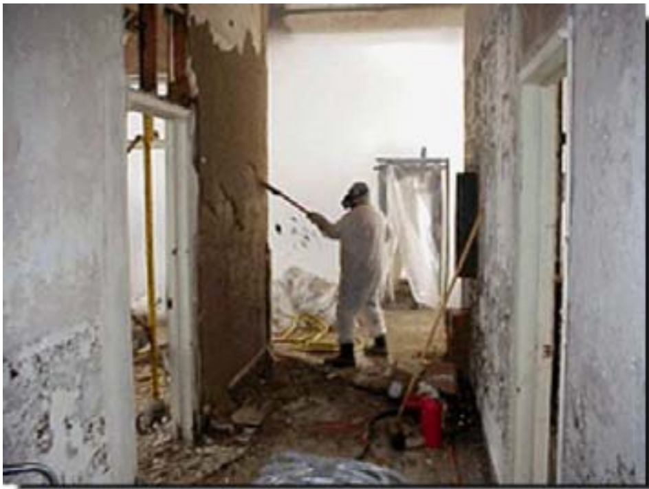
Figura 26 - Rimozione rivestimento dopo il trattamento
