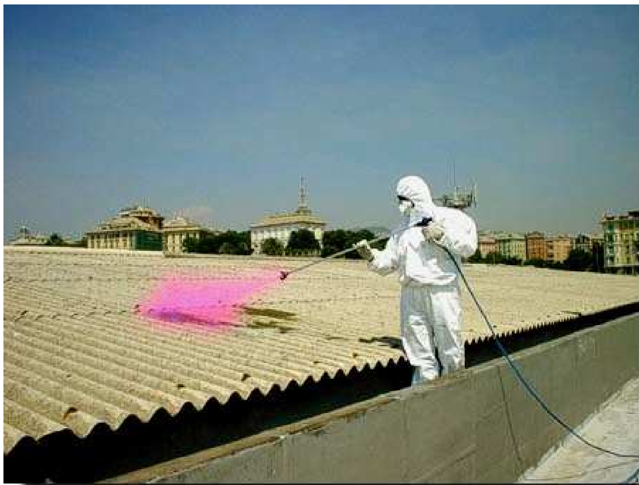
Figura 60 - Bagnatura del cemento-amianto
