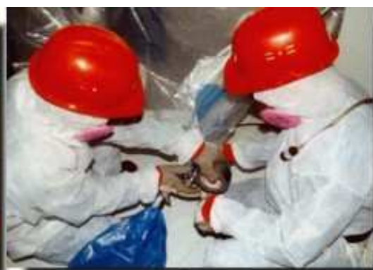
Figura 56 - Sigillatura del sacco con nastro
