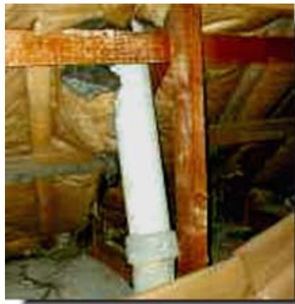
Figura 6 Canne fumarie in cemento-amianto
