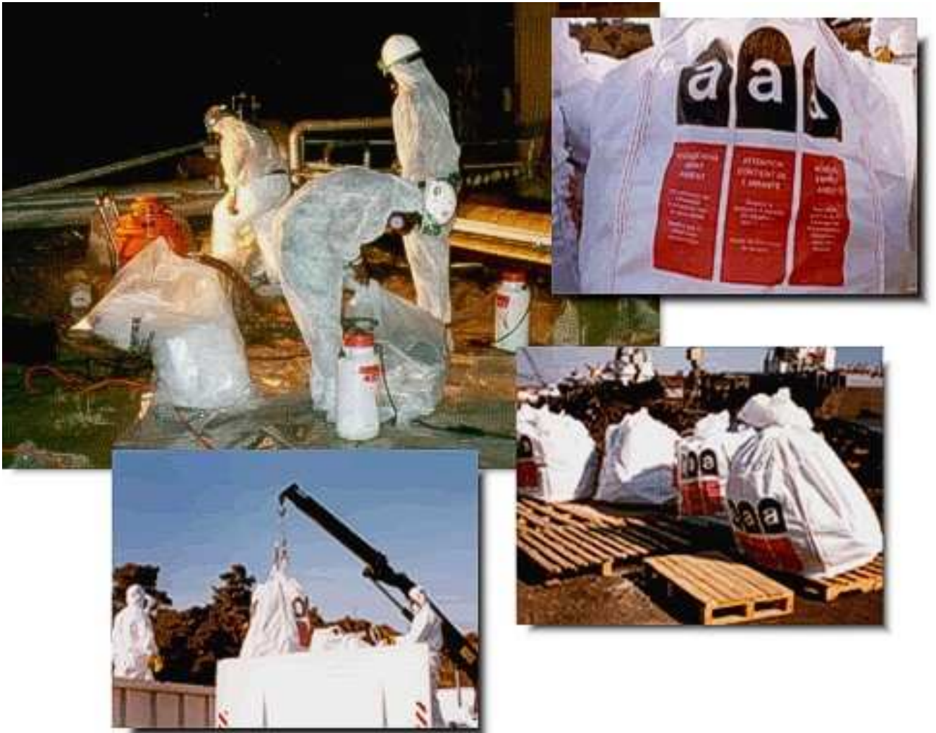
Figura 48 - Confezionamento, etichettatura ed allontanamento dei rifiuti
