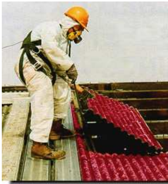
Figura 15 – Rimozione lastre in eternit
