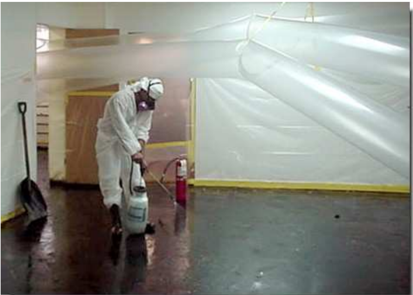
Figura 20 - Confinamento statico e dinamico
