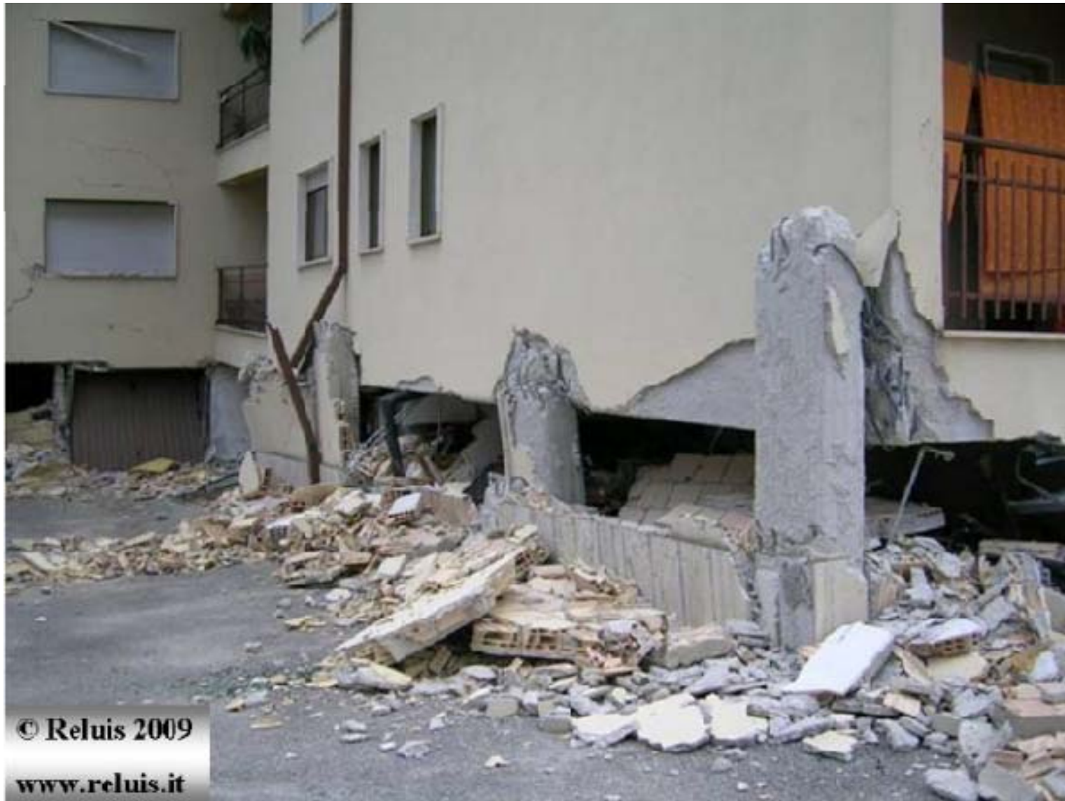
Collasso strutturale con espulsione esterna dei pilastri in c.a. e schiacciamento del piano terra per il cedimento del nodo pilastro-trave non adeguatamente armato.
