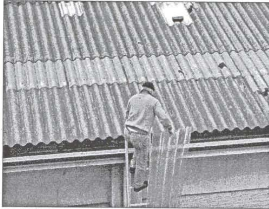
Un capannone con eternit
