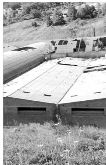
Capannoni di eternit a Santa Caterina Albanese
