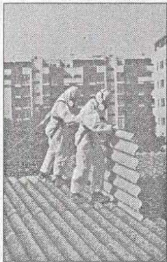
Bonifica del pannelli di amianto presenti in molte strutture
