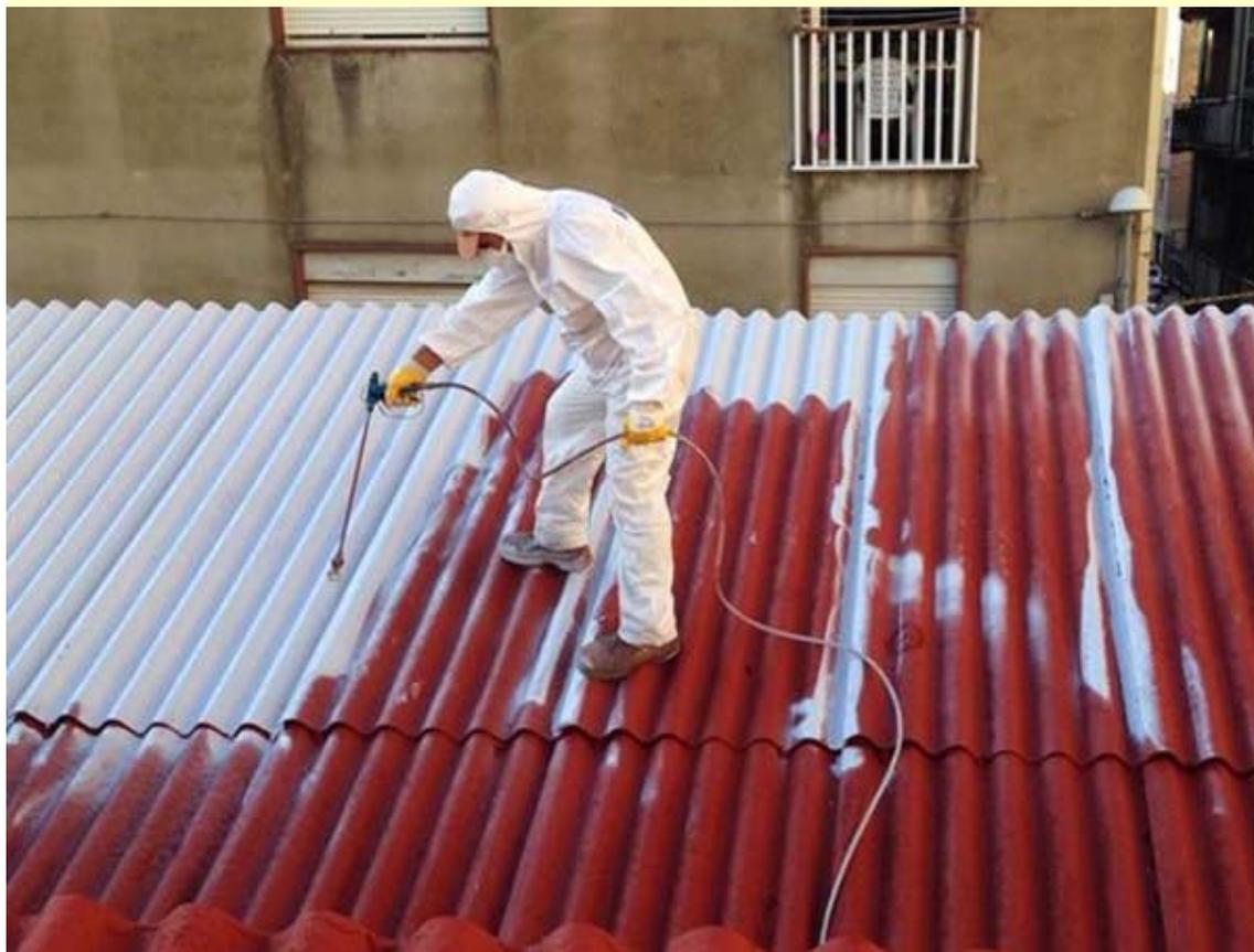
Consiste nel trattare il materiale con **prodotti penetranti** per inglobare le fibre e ripristinare l'aderenza al supporto oppure **ricoprenti** per costituire una pellicola di protezione sulla superficie.
