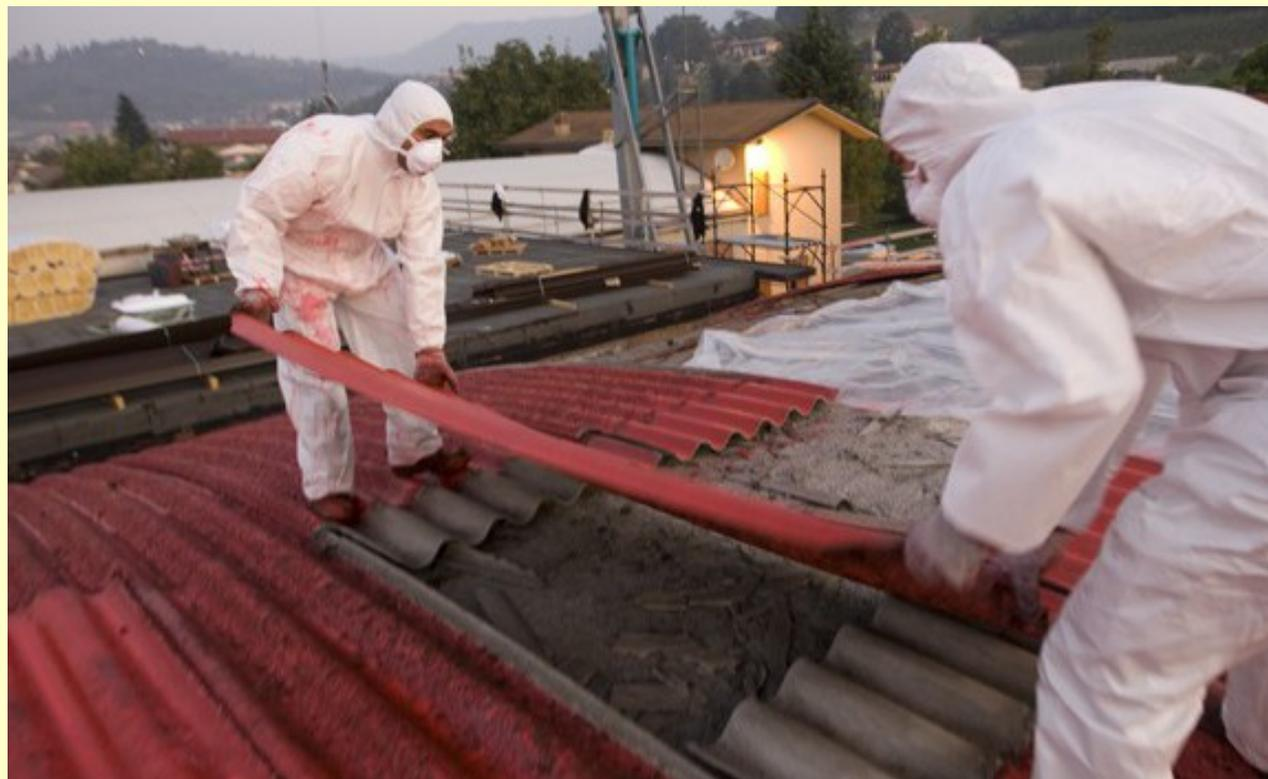
Consiste nella eliminazione del materiale contenente amianto mediante l'asportazione completa e smaltimento. E' necessaria in caso di demolizione di strutture e/o impianti con presenza di amianto.
