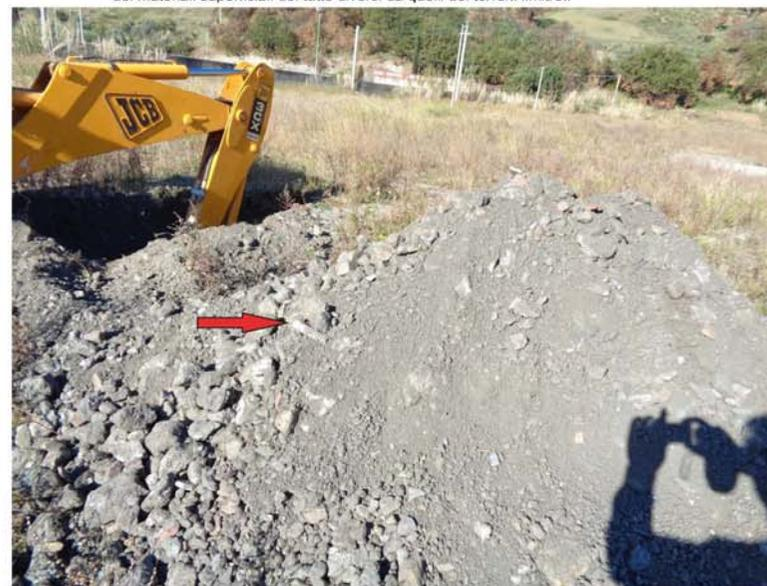
Foto N°4: con l'approfondimento dello scavo si osserva presenza di materiali di varia colorazione, frammenti a pezzi di mattoni, mattonelle, materiale cementizio e plastico; la freccia indica un grosso tassello in plastica
