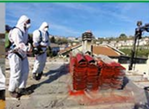
Operazioni di bonifica
