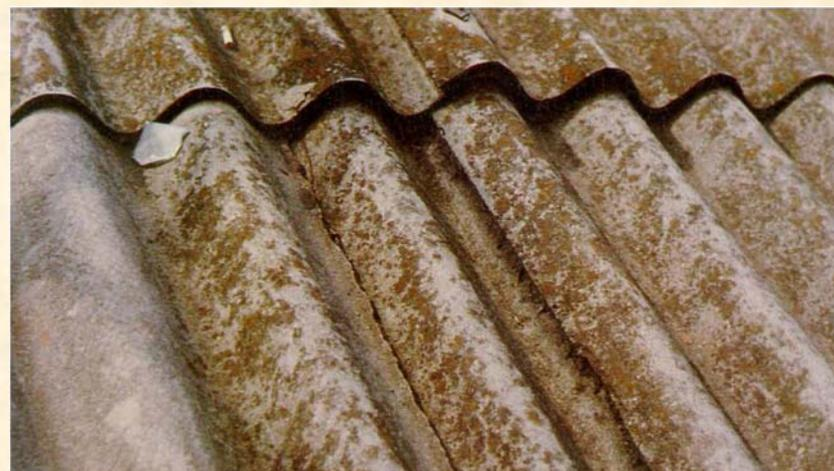
Stalattiti filamentose in corrispondenza dei punti di gocciolamento delle lastre ondulate di Eternit.
