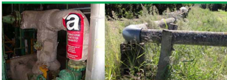
Coibentazione in amianto friabile
