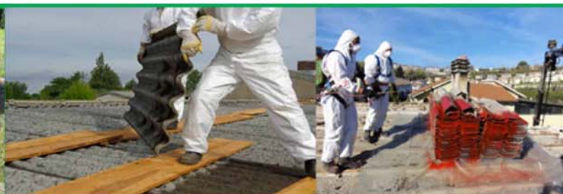
Operazioni di bonifica
