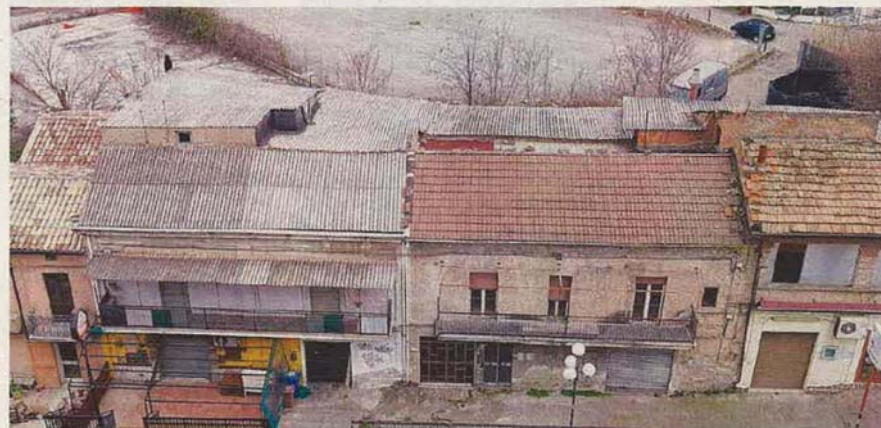
Numerosi gli edifici che hanno ancora tetti in eternit. Un immobile segnalato dall'Ona in via Kennedy a Rende
