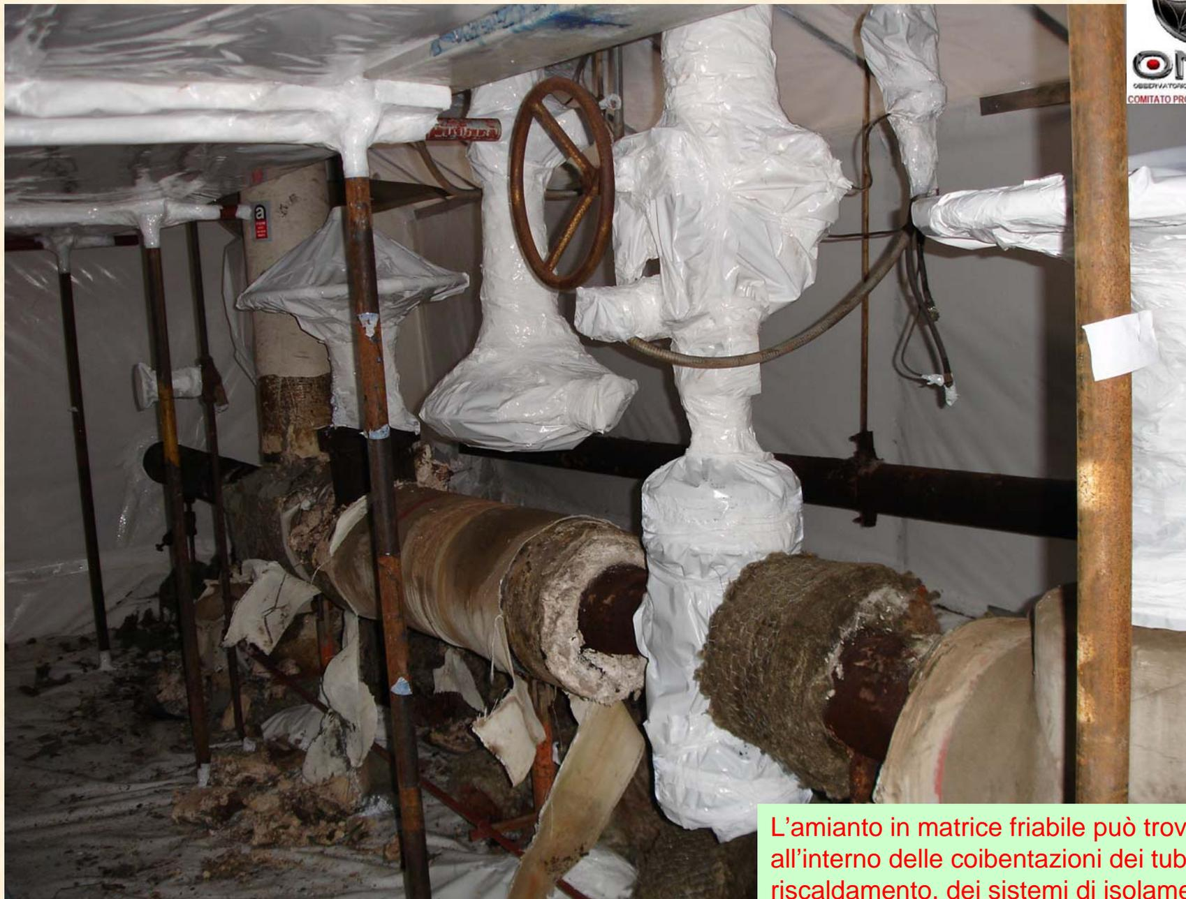
L'amianto in matrice friabile può trovarsi all'interno delle coibentazioni dei tubi del riscaldamento, dei sistemi di isolamento termo-acustico delle pareti, ecc
