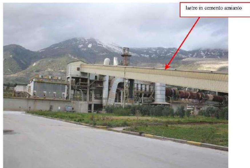
**P.V. 6 - FOTO N°7:** pannelli grigliati (lastre dogate) in cemento amianto capannone deposito cemento (14) - parte non bonificata
