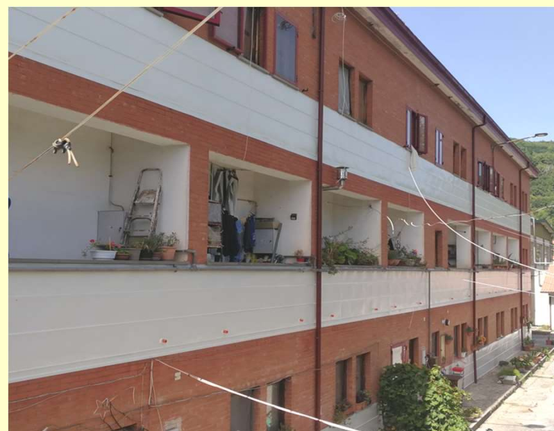
Dopo la sostituzione
