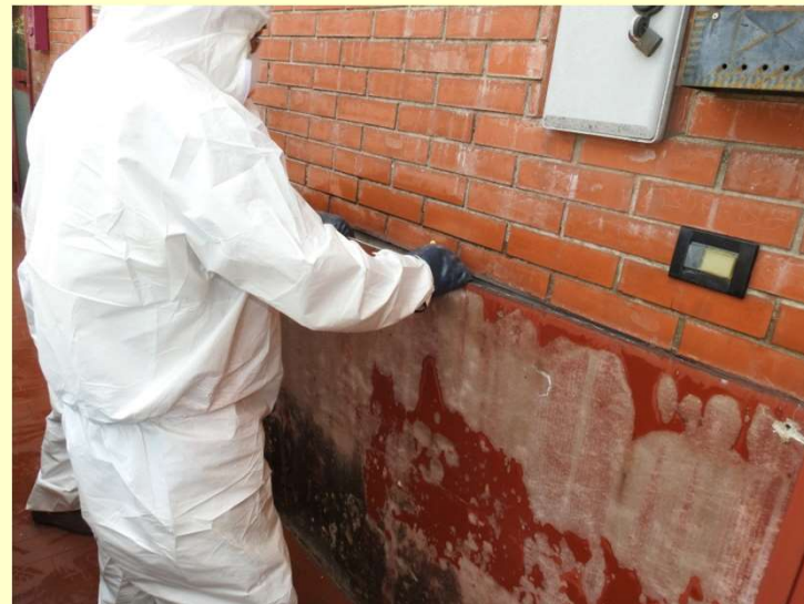
Fase di rimozione
