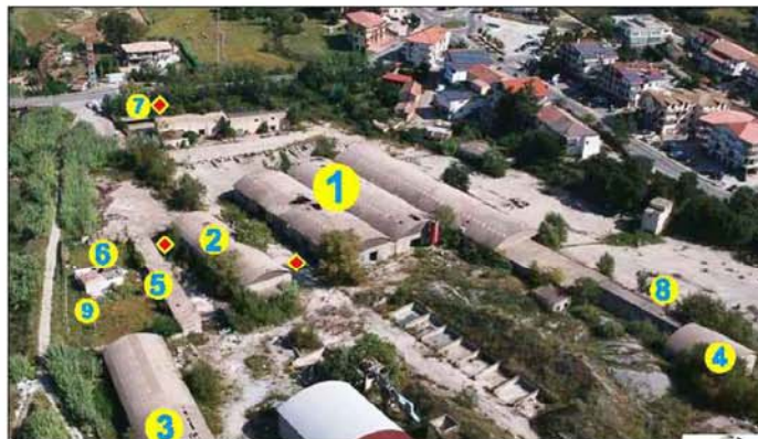
STATO DEI LUOGHI ANTE BONIFICA RIPRESA CON DRONE
