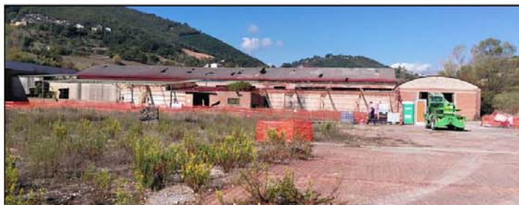
L'accesso al cantiere ed apprestamenti (recinzione, UDP, automezzi, ecc..)
