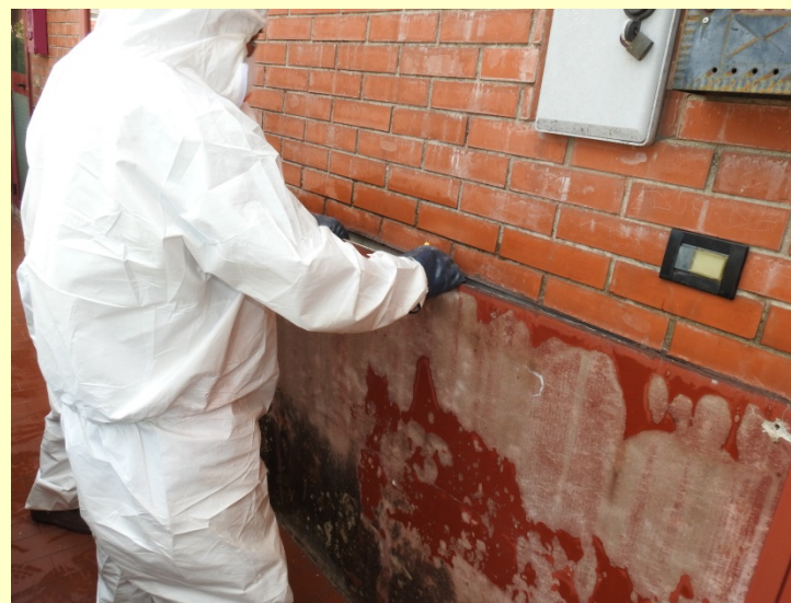
Fase di rimozione
