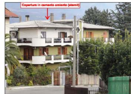
Vista dell'edificio prospiciente Viale della Resistenza (fronte sud)
