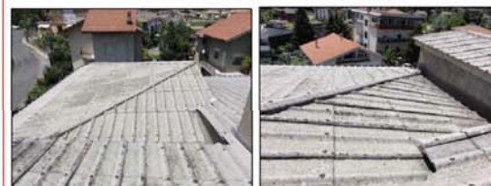
Altre falde secondarie della copertura
