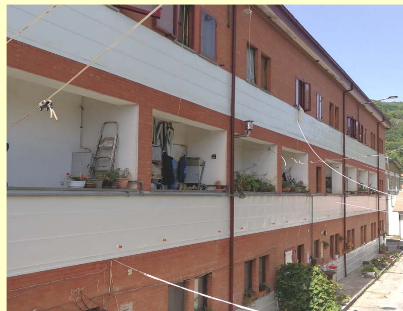
Dopo la sostituzione
