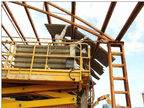
b) Rimozione lastre in cemento amianto da piattaforma (interno/esterno)
