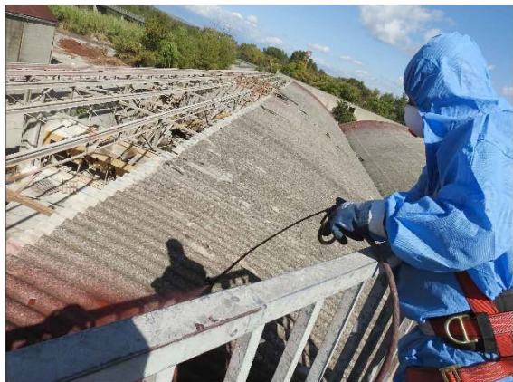
a) Applicazione incapsulante temporaneo (inertizzazione)
