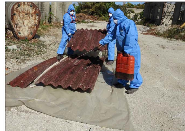
c) Tiro in basso delle lastre, applicazione di ulteriore incapsulante a spruzzo, impilaggio ed imballaggio unità di decontaminazione del personale (UDP)
