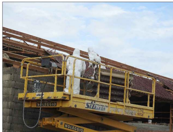
b) Rimozione lastre in cemento amianto da piattaforma (interno/esterno)
