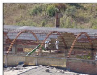
Fase di rimozione delle lastre eseguita a stadi e per settori di strutture
