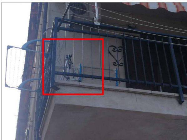
Controllo e monitoraggio su fabbricato residenziale vicino
