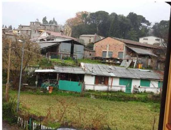
Foto N°10 (PV1) - Vista ravvicinata della copertura del fabbricato «C». Si può notare la presenza di lastre in cemento amianto non integre e/o mancanti, la sovrapposizione di pesi e l'assenza di planarità ed uniformità cromatica della copertura stessa
