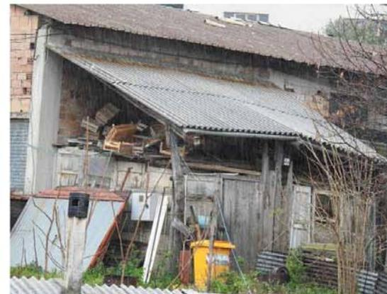
Foto N°9 (PV1) - Vista particolareggiata della tettoia «B». Si evince la non uniformità della falda conseguente a deformazione della struttura portante in legno in precario equilibrio statico
