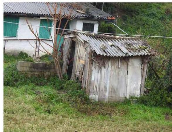
Foto N°12 (PV1) - Vista ravvicinata del fabbricato «D» con evidenza del dissesto sia della struttura portante che delle lastre di copertura, ampiamente in stato di degrado
