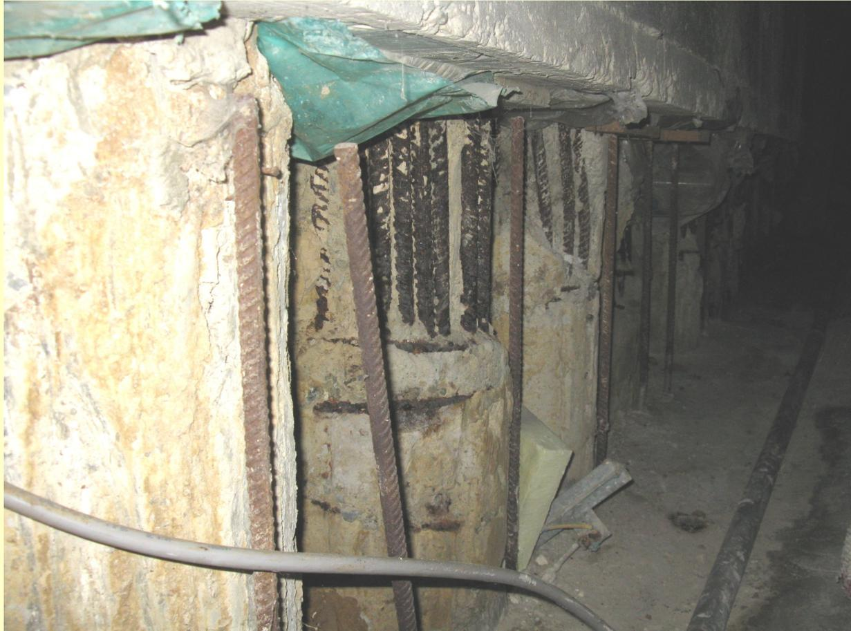
**Si nota la disomogeneità del calcestruzzo, l'irregolarità strutturale del palo, l'avanzata corrosione dei ferri di armatura privi del copriferro ed l'insufficiente interferro**
