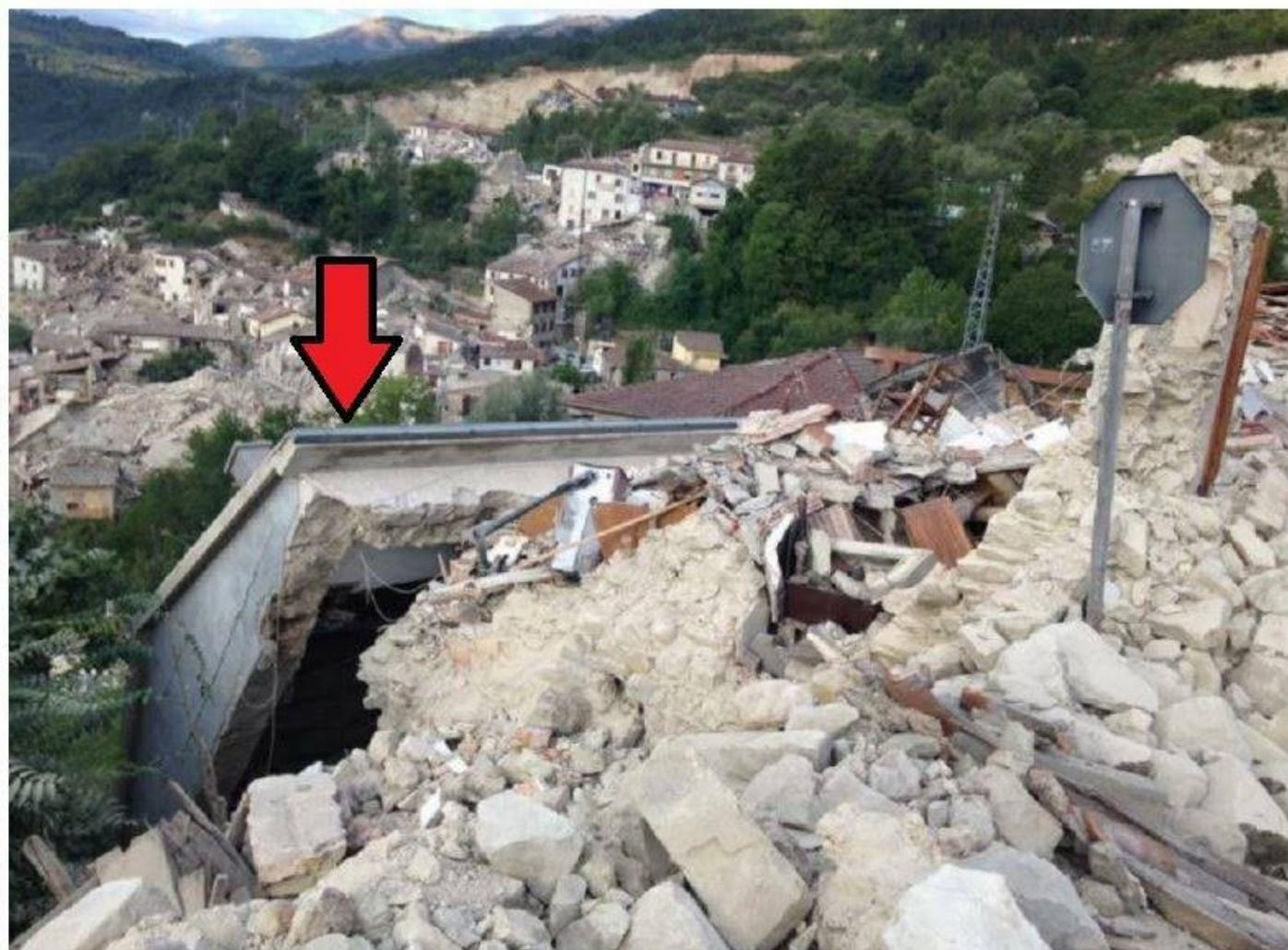
**Copertura pesante e rigida, con murature in pietrame, le quali sono completamente collassate.**
