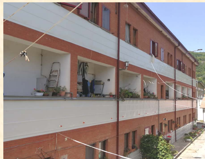
Dopo la sostituzione
