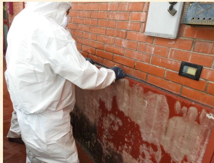
Fase di rimozione
