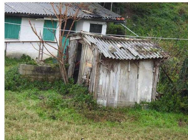
Foto N°12 (PV1) - Vista ravvicinata del fabbricato «D» con evidenza del dissesto sia della struttura portante che delle lastre di copertura, ampiamente in stato di degrado
