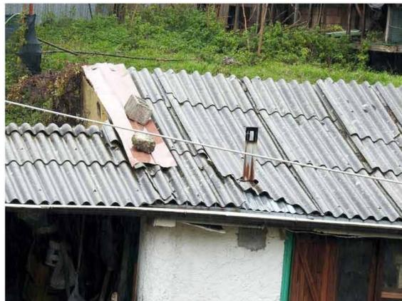
Foto N°11 (PV1) - Particolare del dissesto delle lastre di copertura del fabbricato di cui alla foto precedente, in evidente stato di degrado
