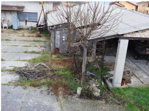
Foto N°7 (PV3) - Vista particolareggiata della falda di copertura del fabbricato «A», lato Ovest. Si nota la mancanza di una lastra in cemento amianto (crollata a terra in data 29.12.2019 come specificato nella Relazione) e la continuità della falda che risulta sostenuta in parte da una struttura in c.a. ed in parte da una struttura in legno, quest'ultima in precario stato di assetto statico (confr. Doc. 2 degli Allegati)
