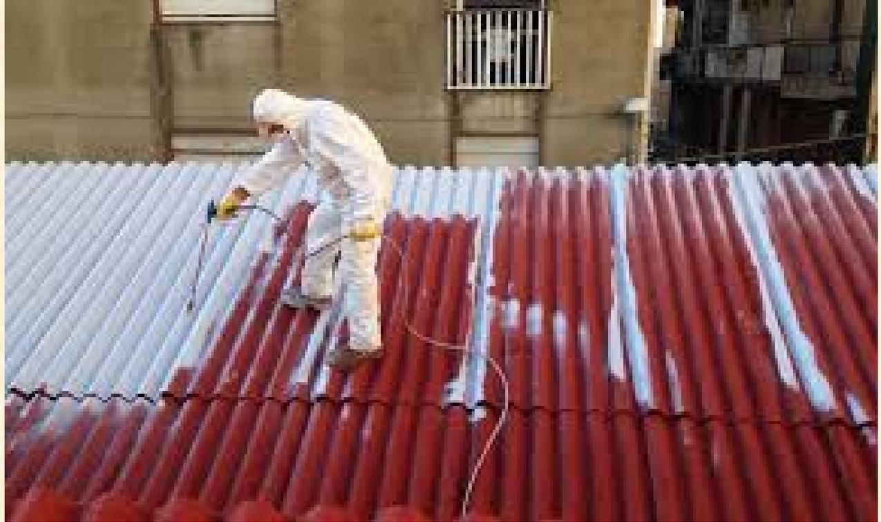
Consiste nel **trattare il materiale con prodotti penetranti per inglobare le fibre e ripristinare l'aderenza al supporto** oppure ricoprenti per costituire una pellicola di protezione sulla superficie
