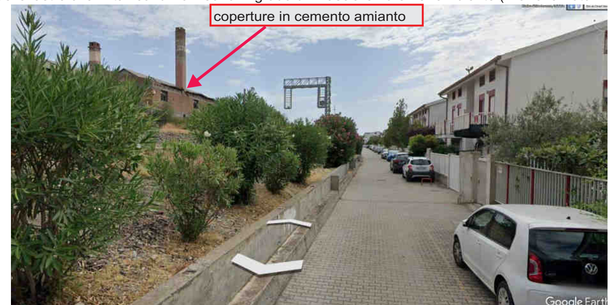
Foto N°13 - Immagine da street view lato sud (08_2022). Particolare della strada di servizio delle villette in adiacenza al tracciato ferroviario, nelle immediate vicinanze dell'area contaminata dalla presenza di materiali sgretolati (lastre) in grado di emettere fibre d'amianto (v. Foto N°12)
