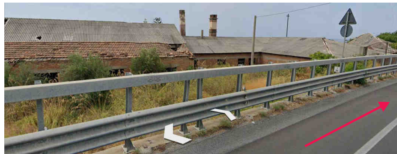
Foto N°11 - Immagine da street view (08_2022)- Vista delle coperture in cemento amianto delle vecchie strutture della ex fabbrica site in adiacenza alla S.S. 106 in stato di abbandono e di rovina. Si evincono le condizioni di estremo degrado delle lastre che in tali condizioni sono in grado di rilasciare fibre nell'ambiente (v. anche Foto N°12)
