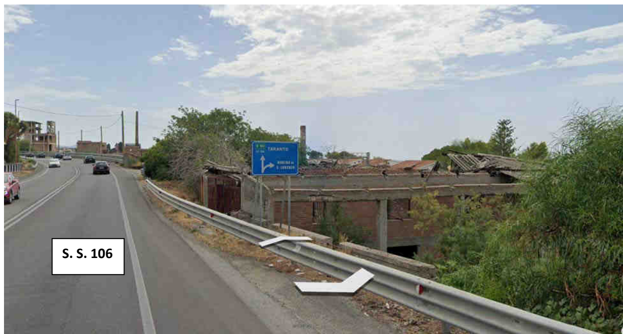
Fig. 4 – Immagine raffigurante il crollo della copertura delle strutture poste nella Zona ovest dell'area (vista direzione ovest verso est –Street View anno 2022)
