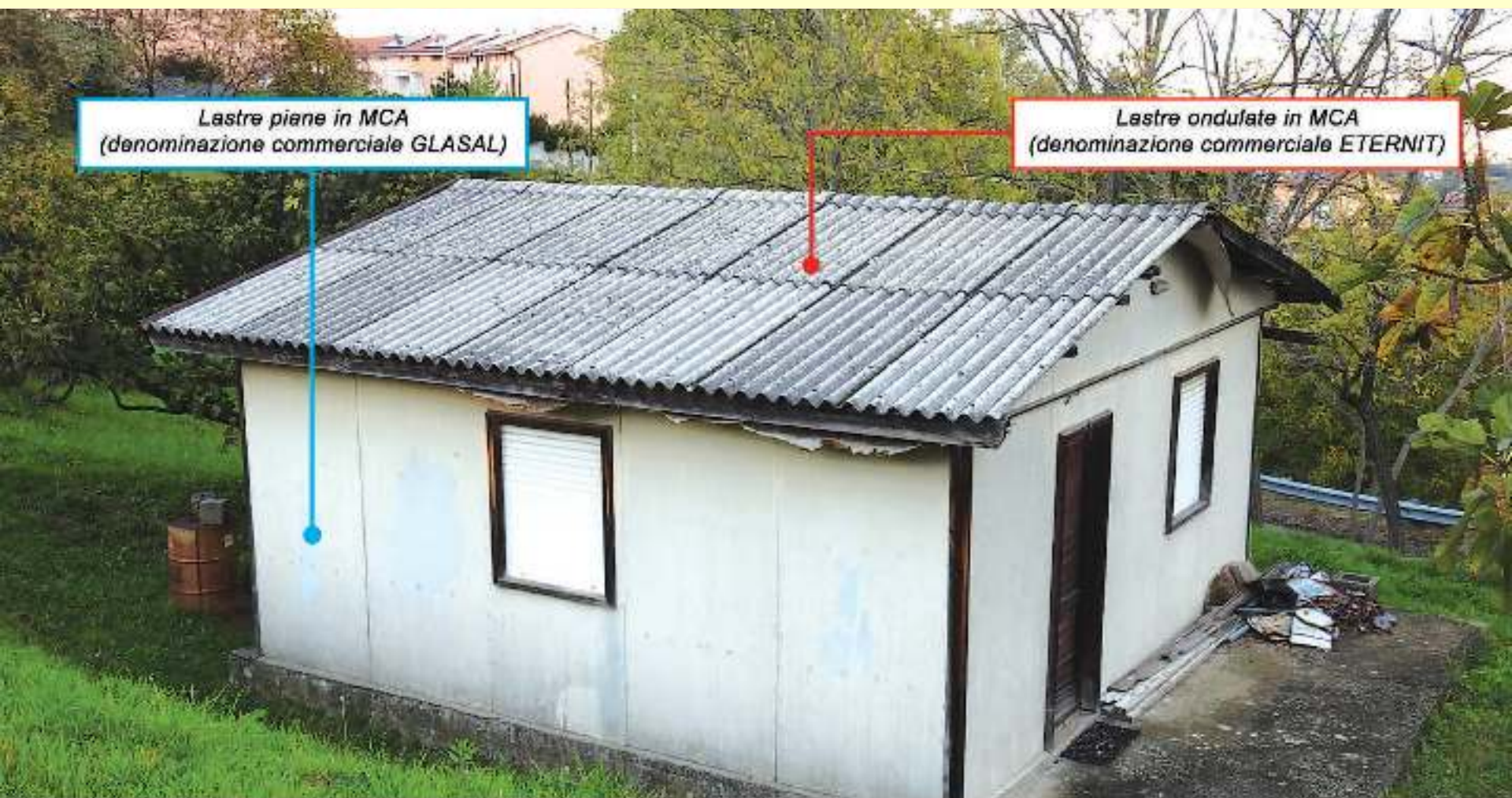
Modulo abitativo prefabbricato provvisorio usato per le aree terremotate del 1980. La copertura e le pareti esterne sono costituite da lastre in MCA. Ne esistono degli esemplari anche in Calabria
