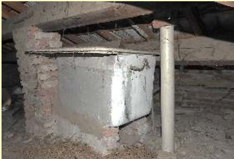
Serbatoio in un sottotetto (condizione frequente)
