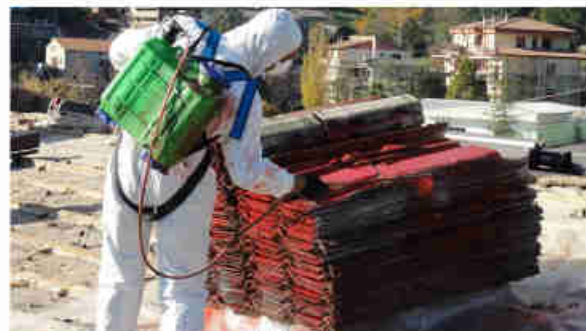
rimozione di lastre di copertura
