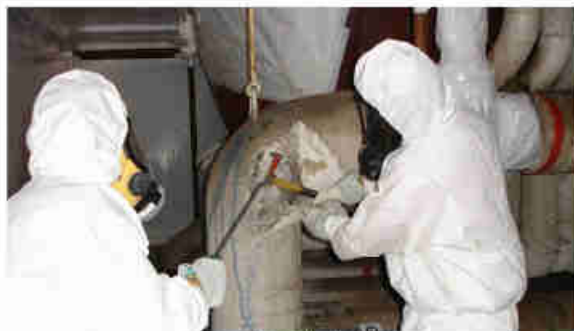
scoibentazione di tubazioni
