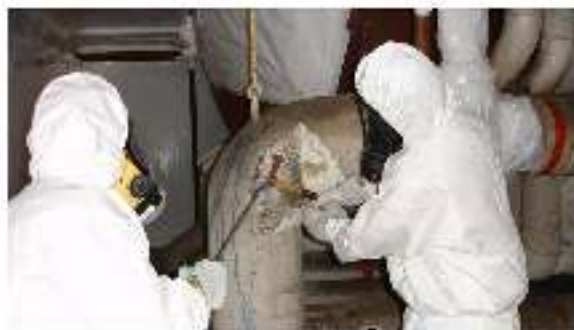
rimozione di tubazioni
