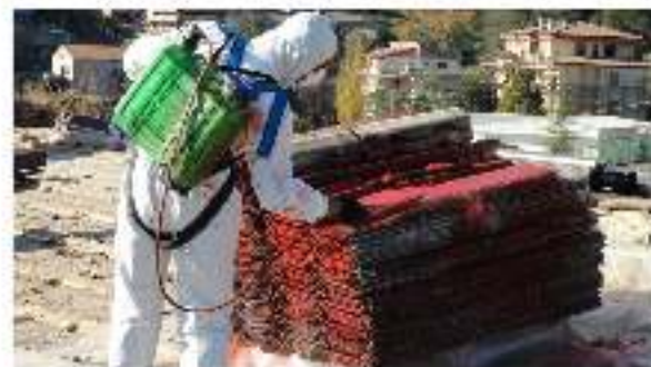
trattamento di bene di copertura
