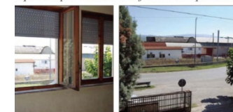
Ex cartiera nell'entro del comprensivo. A destra lo stato con la copertura in eternit
